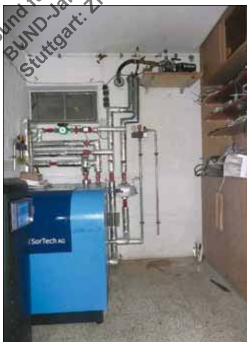
Es wird eng im Keller: links der Pufferspeicher und in der Mitte die Kältemaschine „ACS 08“ von SorTech. Rechts die fünfköpfige Familie Brinkmüller.
