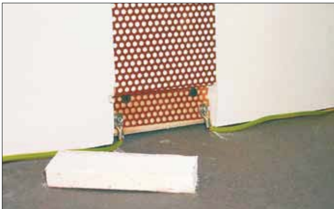
Vor dem Putzauftrag montiert der Fachmann ein Ableitblech, damit ist die Abschirmung geerdet.
