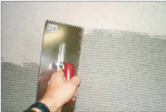
Lehmabschirmputz enthält Karbonfasern und wird mit der Zahntraufel aufgebracht.
