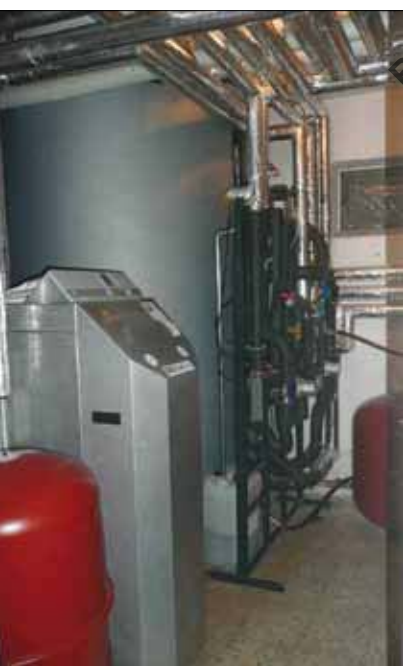
Es wird eng im Keller: links der Pufferspeicher und in der Mitte die Kältemaschine „ACS 08“ von SorTech. Rechts die fünfköpfige Familie Brinkmüller.
